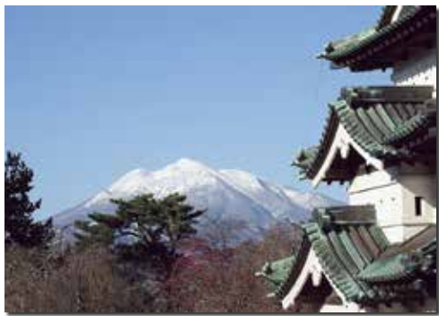
津軽富士と弘前城天守（曳屋後）
