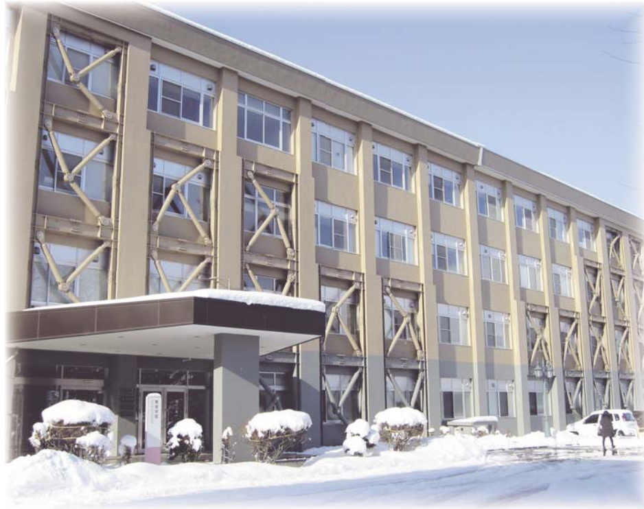
全面改修を終えた「教育学部校舎」正面玄関付近
